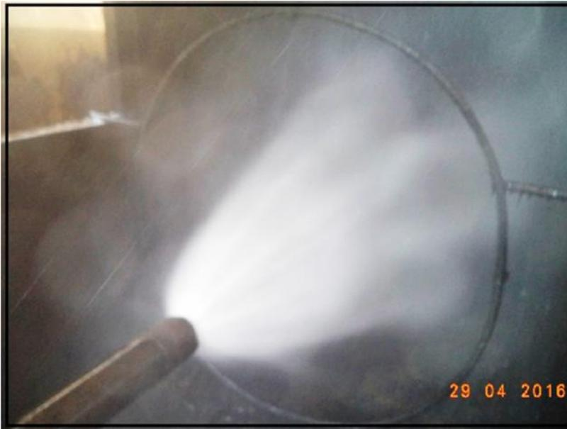
**Figura 3.4.** Atomización deficiente en banco de quemadores
