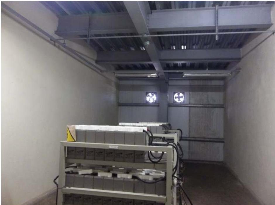
Figura 3.9 Banco de Baterías existente.
