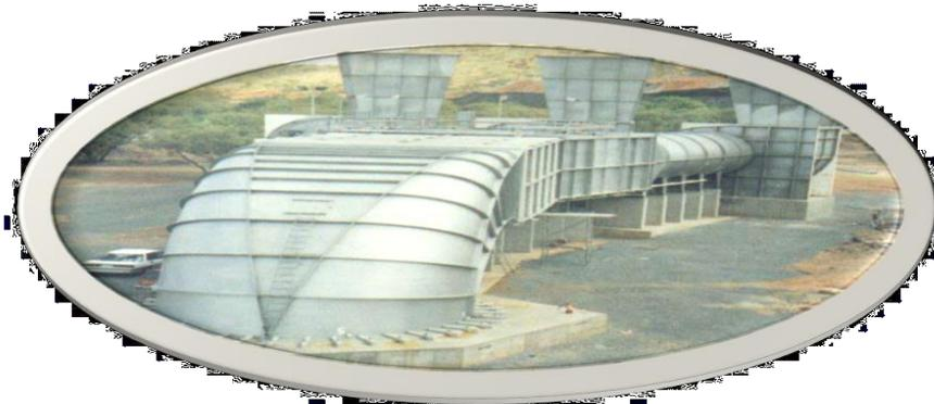
**Figura 1.6: Ventiladores tipo Centrífugo**
