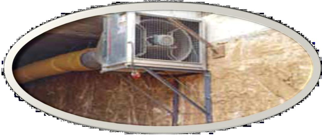
Figura 1.1: Ventilador a la entrada de un túnel en construcción.
