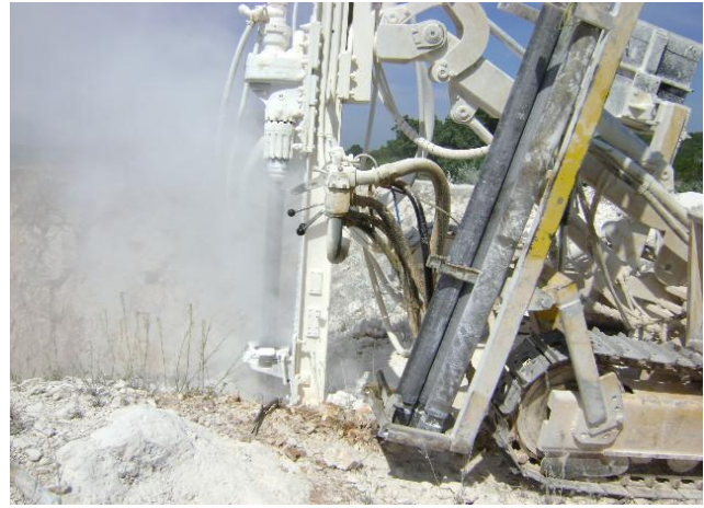
Emisión de polvo durante la perforación.
