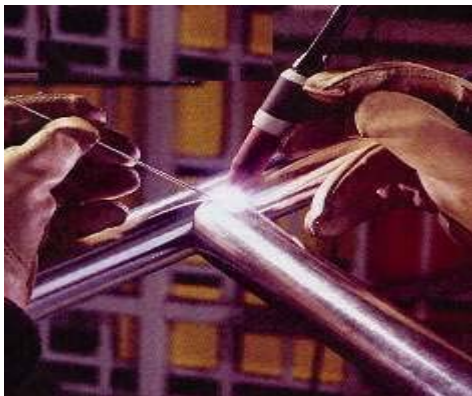
Figura 1.3. Proceso de soldadura de gas y tungsteno. Fuente: Capdevila (2008)
