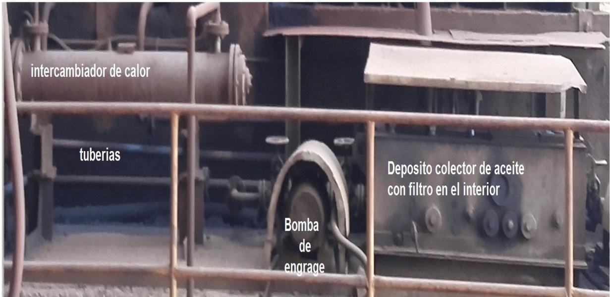
Figura 3.1. Sistema de circulación de aceite para la lubricación de los rodamientos 22330 del ventilador centrífugo 121-02-UE-22.
