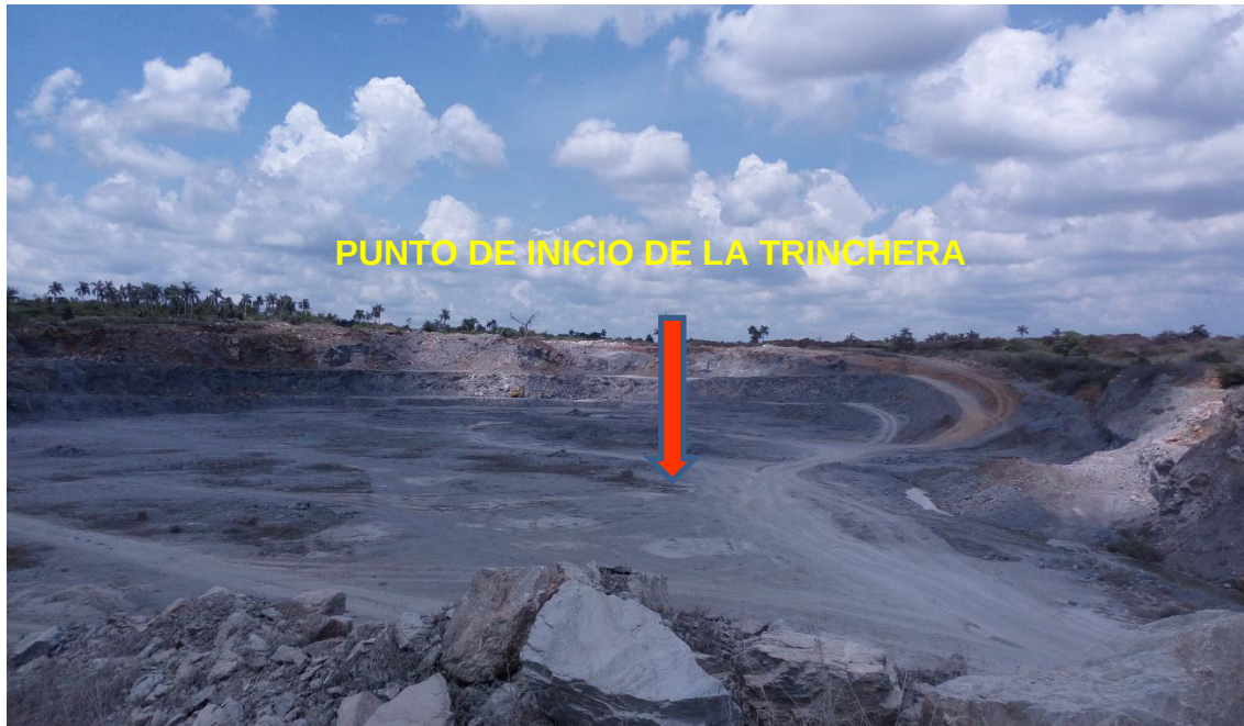
Fig. 2.1. Punto de inicio de la trinchera de acceso
