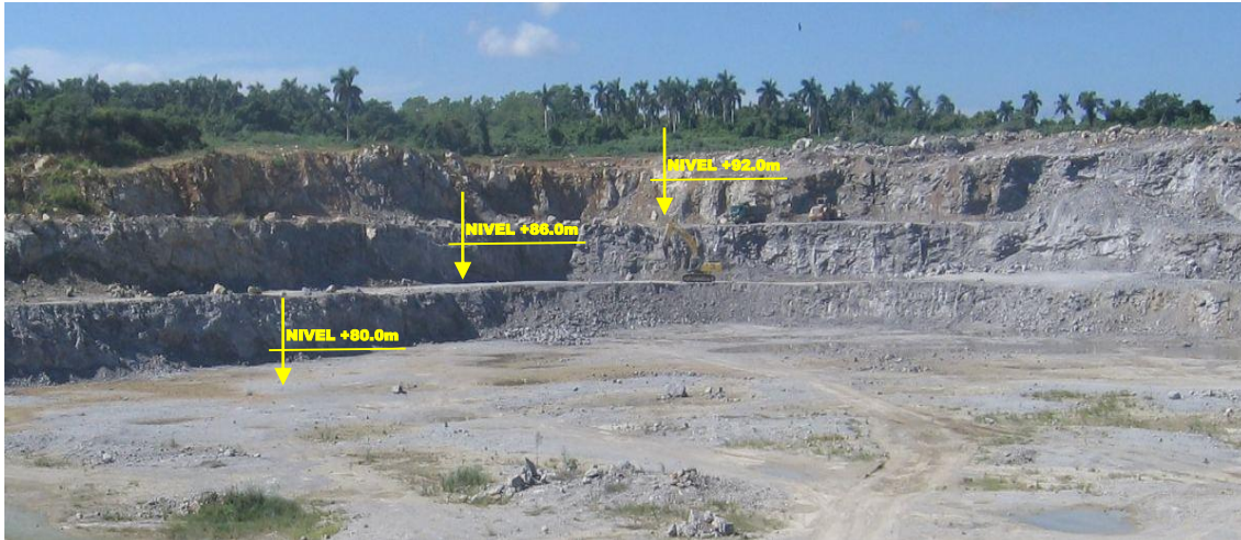
Fig. N° .3.5. Vista niveles de explotación.
