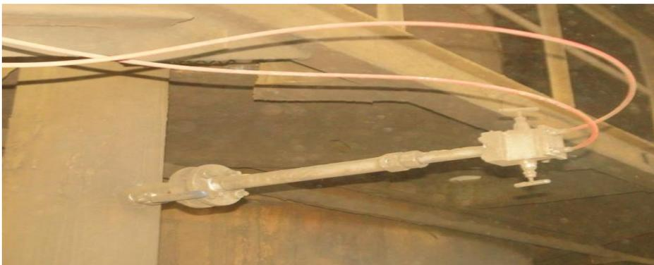
**Figura 2.2.** Medición de caudal en la línea  $\varnothing$  0,3 m que alimenta las cámaras de combustión
