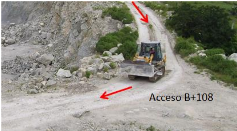
Figura 14 Acceso actual al Banco +108.0 m
