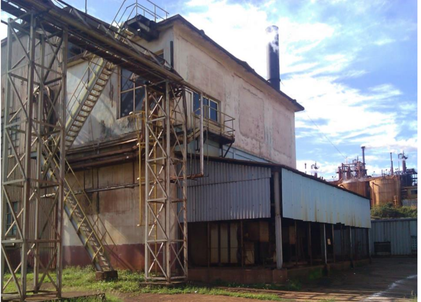
Anexo # 4. Termo-Eléctrica Fabrica Empresa Comandante Pedro Sotto Alba
