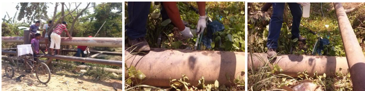
Figura 23. Muestreo de la Tubería de aducción.
