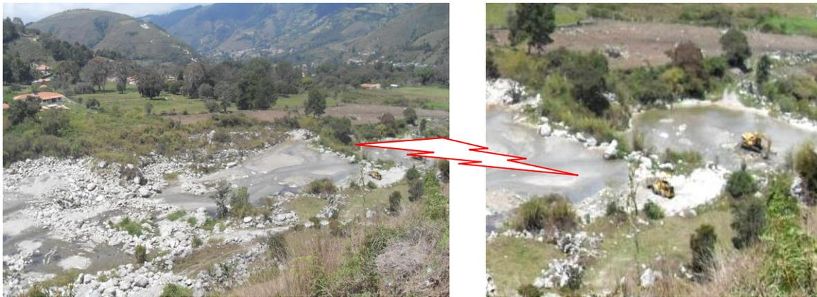
Figura 9. Extracción de arenas gravas: plazoletas de sedimentación contribuyen a minimizar la pendiente, reducir la velocidad del río y controla la descarga de sedimentos por niveles de acumulación, Qda. La Mucuy, Tabay.
