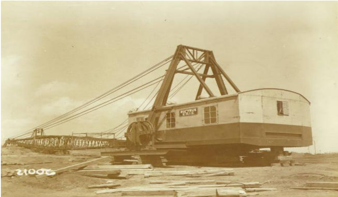
Figura 2.1 Dragalina Bucyrus Erie: utilizada para la Extracción de Mineral al iniciar las operaciones mineras para la fábrica. (Fueron utilizadas hasta finales de la década del 80).
