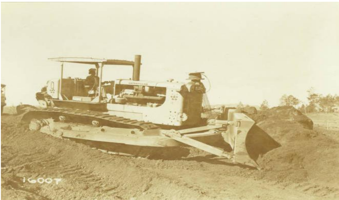
Figura 2.2 Tractor Cartepillar: utilizado en el Laboreo Minero al iniciar las operaciones mineras para la fábrica.
