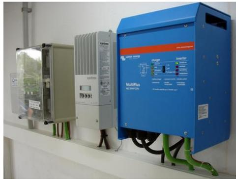
**Fig.1.7 Inversor fotovoltaico conectado a la red eléctrica. (Cortesía victron energy)**
