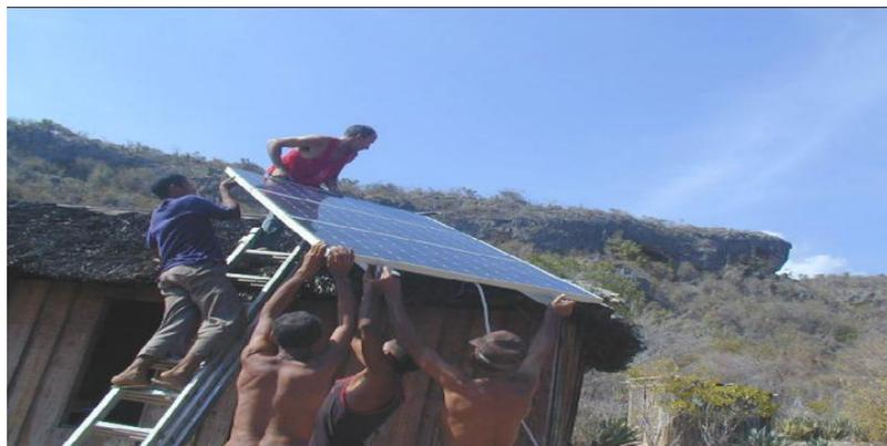
**Fig.1.1- Instalación SFV para una vivienda aislada.**
