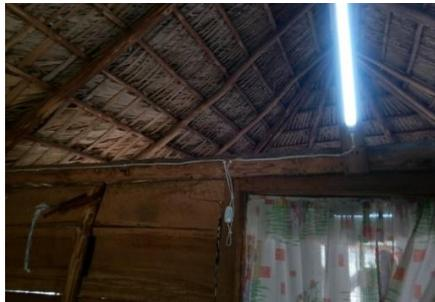
Fig.1.8- Luminaria fluorescente para sistemas fotovoltaicos aislados.
