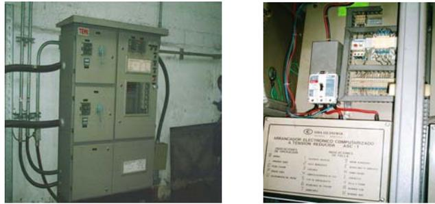
**Figura 1.4** Tablero de control del Sistema de Bombeo. Vista externa e interna
