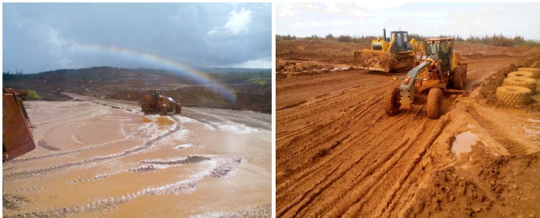
Figura 3.1 y 3.2. Grandes espesores de lodo frente a la caseta de muestreo.
