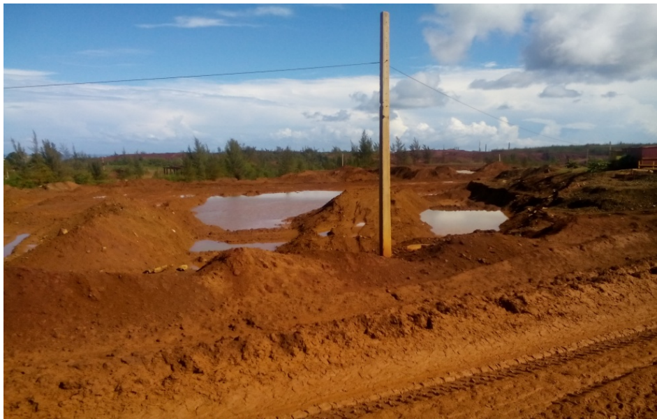
Figura 2.5. Acumulación de las aguas pluviales.
