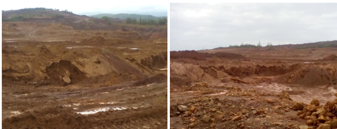
Figura 3.4 y 3.5. Desprendimientos y deslizamientos en las laderas y taludes que bordean las plazoletas.
