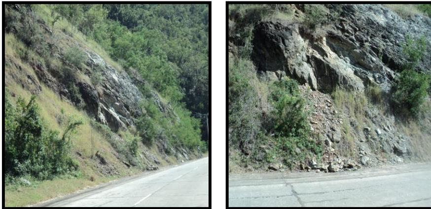
Fig.33 Desprendimientos de rocas y Flujos detríticos
