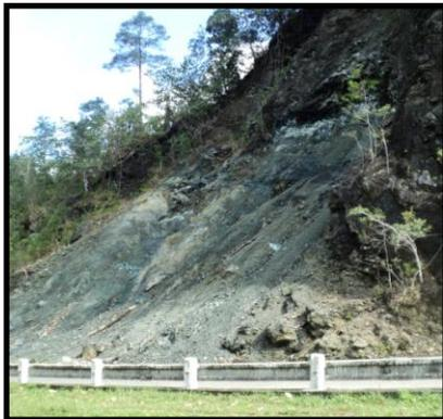
Fig. 46 Talud con evidencia de deslizamiento
