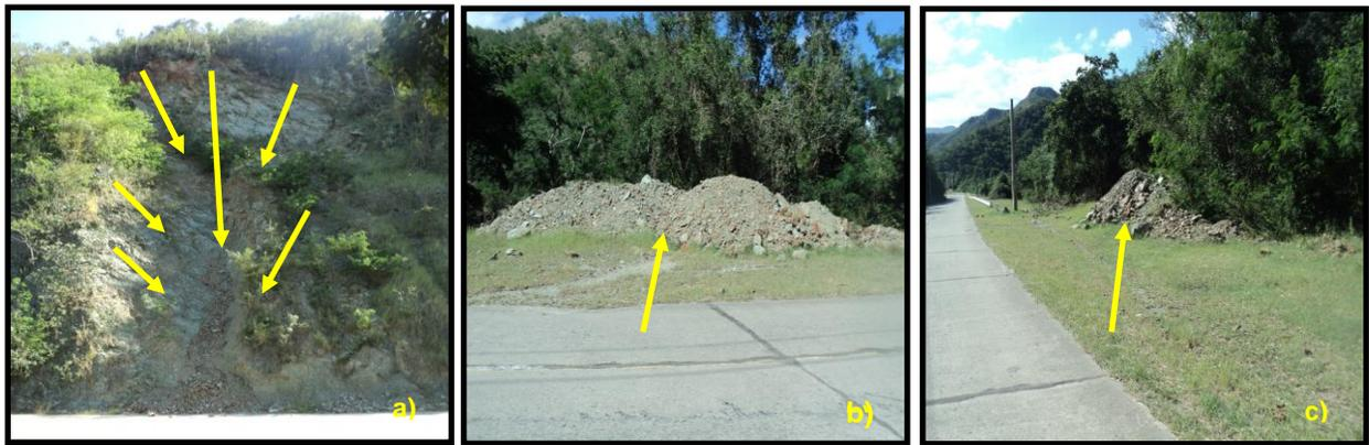
Fig. 30 a) Talud con evidencia de deslizamiento; b y c) cúmulos de material deslizado al borde de la vía. (Flujos detríticos).
