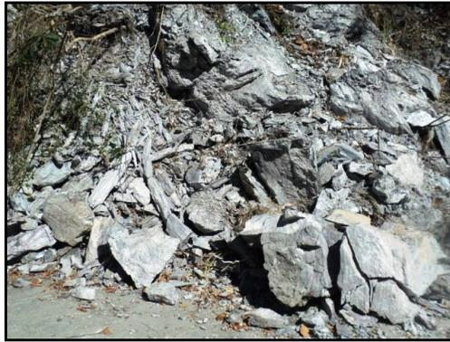
Fig. 15 Desprendimiento de bloques en el talud de la carretera.
