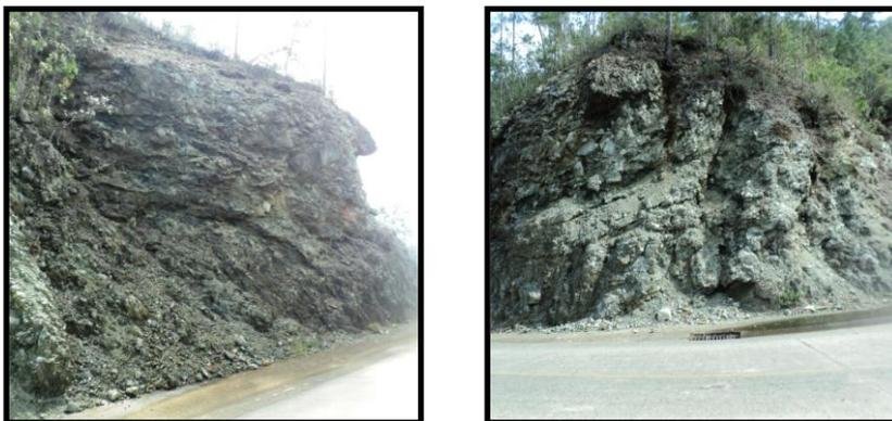
Fig. 45 Talud con intenso agrietamiento.
