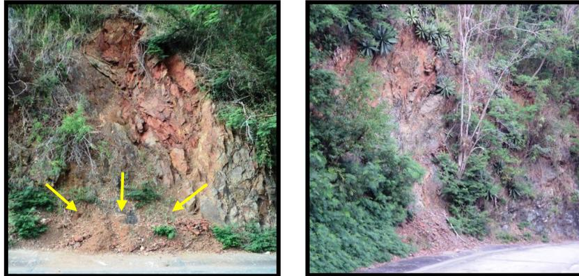
Fig. 43 Talud con evidencia de deslizamiento y material detrítico.
