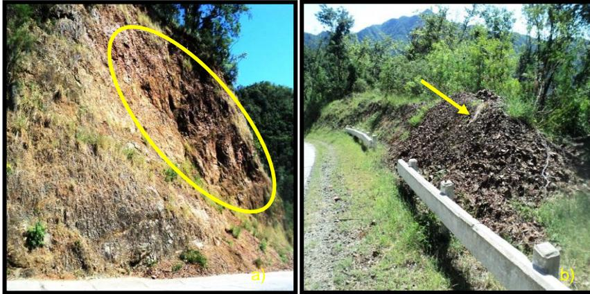
Fig. 38 a) Evidencia de deslizamiento ocurrido; b) cúmulo de material deslizado.
