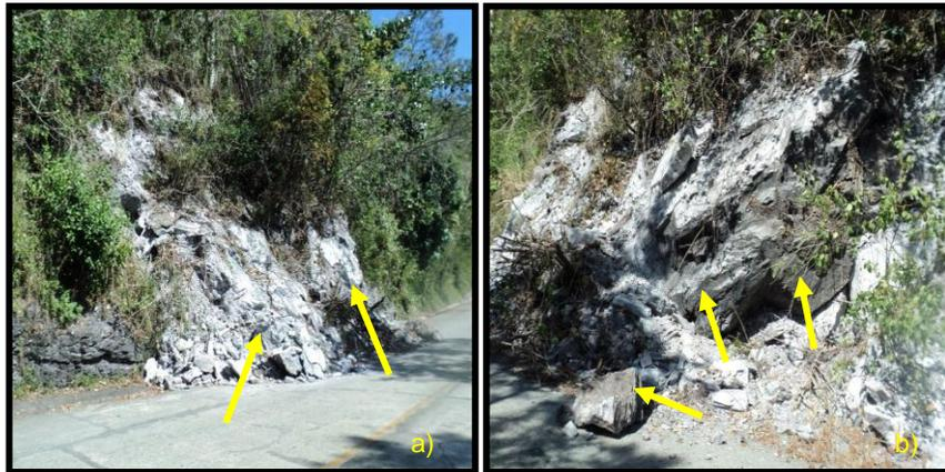
Fig. 44 a) Deslizamiento rotacional; b) Desprendimientos de rocas.
