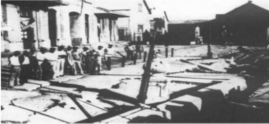
Figura 3: Foto. Licuefacción de los suelos en calle La Alameda, en Santiago de Cuba. Terremoto del 3 de febrero de 1932, Chuy, 2002 (tomado de Herrera – Delfin, 2015).
