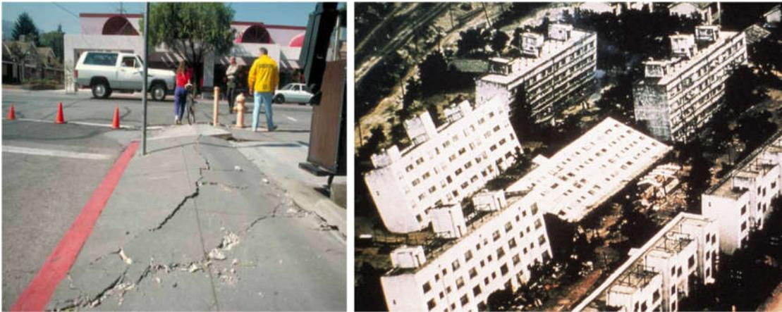
Figura.1 Efectos del fenómeno de Licuefacción de los suelos en Niigata, Japón, 1964. (<http://www.planetacurioso.com/2008/12/16/sabias-que-existen-terremotos-donde-el-suelo-se-comporta-como-liquido/>, 2008)
