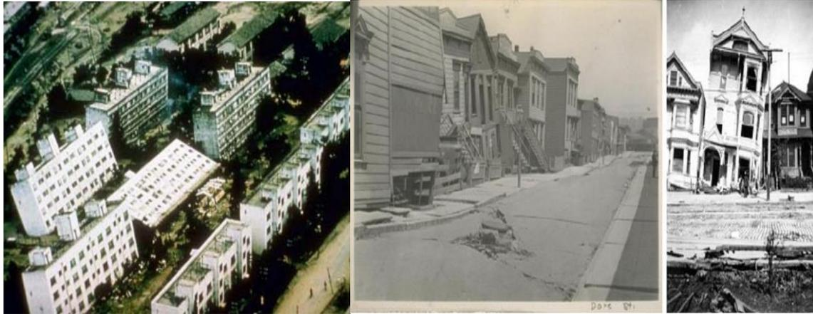
**Figura 1.** Izq. Efecto de la licuefacción en edificios post terremoto de Niigata 1964. Drch. cráteres de arena en el área de Milpitas luego del terremoto de San Francisco en 1906.
