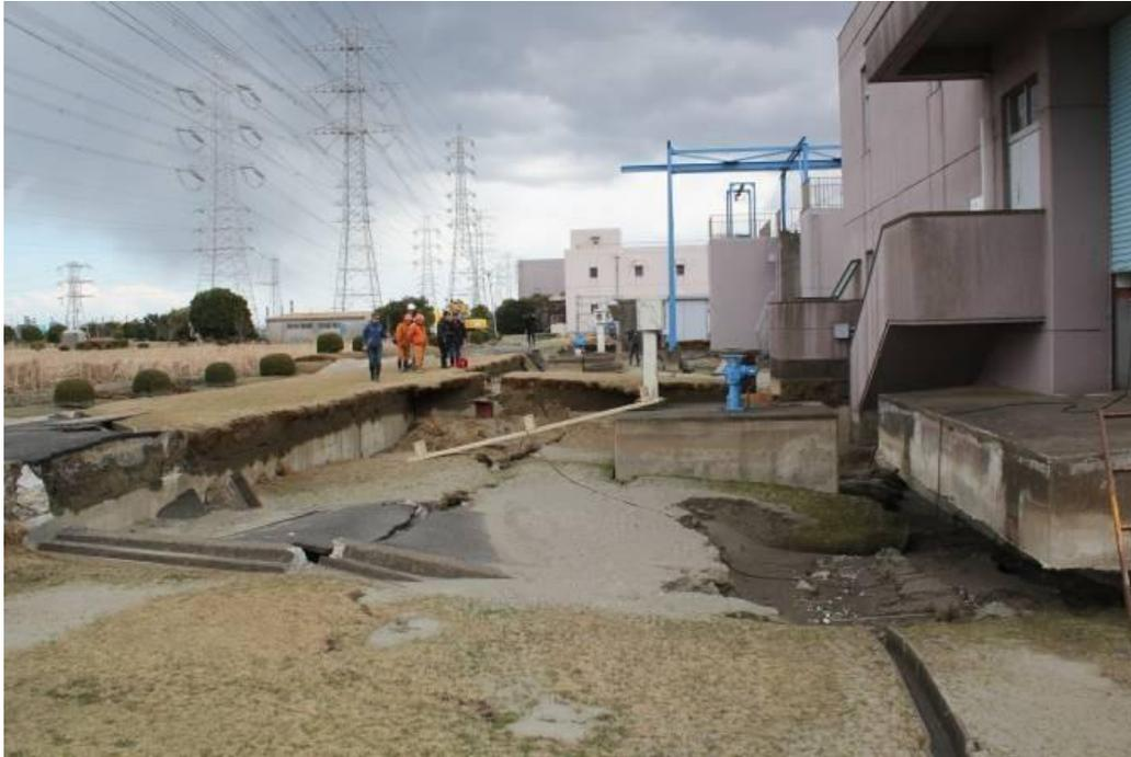
**Figura 7.** Estructuras hundidas por la licuefacción. (Foto: Scott Ashford, Oregon State University).
