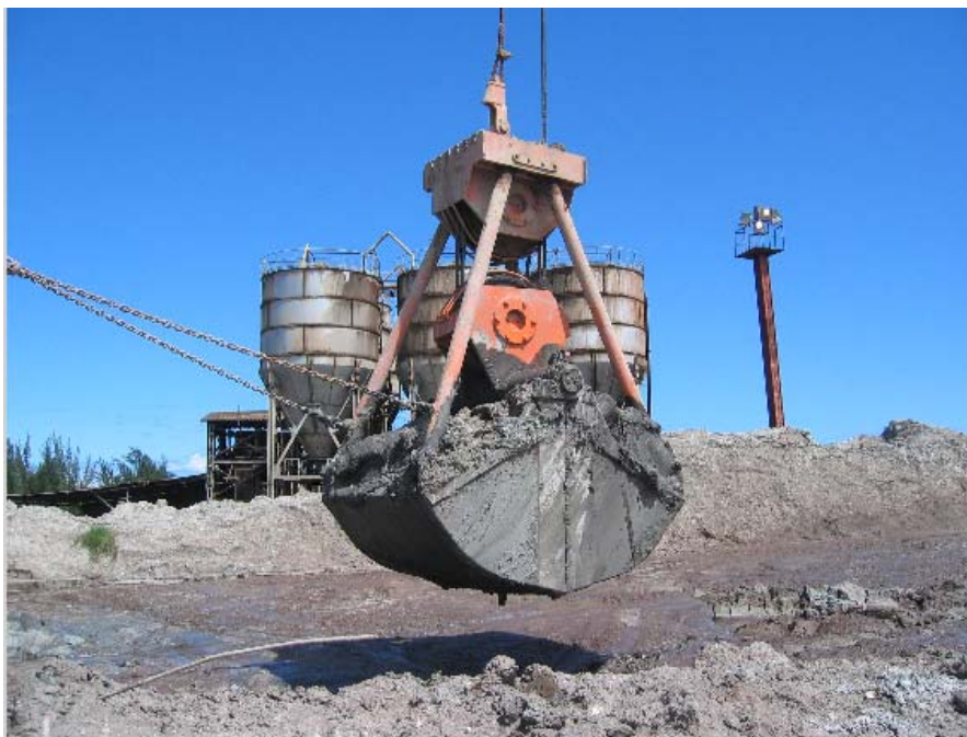
Figura 8 Depósito de alimentación a la torre
