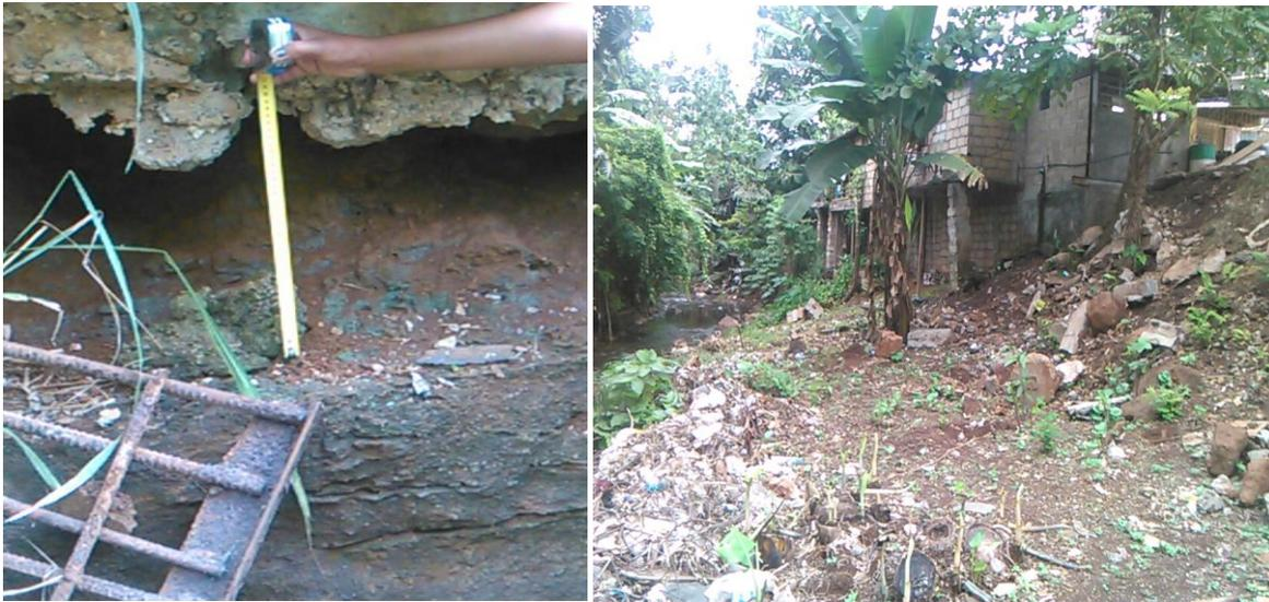
Figura 20. Socavación del arroyo en los cimientos de viviendas
