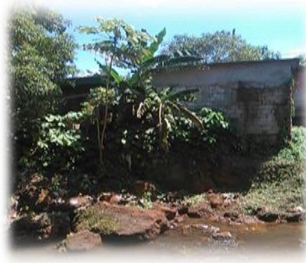
Figura 19. Deslizamientos de bloques en la ribera del arroyo
