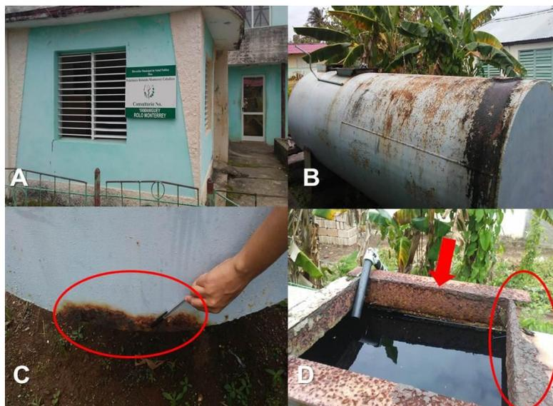
Figura 13. **A:** Policlínico Rolando Monterrey Caballero, **B:** tanque metálico de almacenamiento de agua del policlínico, **C:** sector oxidado del tanque en la parte inferior, **D:** tanque sin tapa y sectores oxidados.
