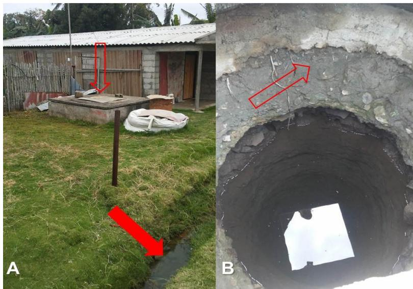
Figura 14. **A:** ubicación del pozo tapado y presencia de una zanja enfrente, **B:** pozo con las paredes reforzadas de cemento.
