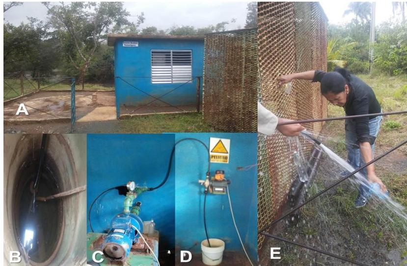
Figura 10. **A:** estación de bombeo de Yamanigüey, **B:** tubo de extracción del agua para bombeo, **C:** turbina utilizada para el bombeo, **D:** proceso de clorado de las aguas de distribución, **E:** obtención de la muestra en el lugar.
