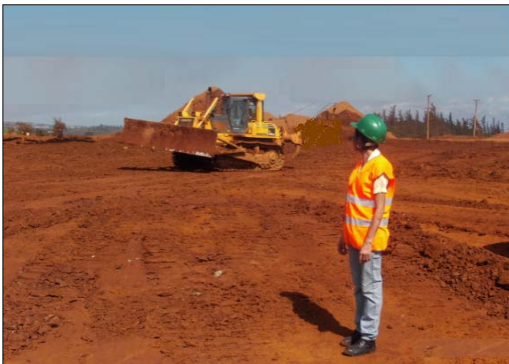
Figura # 2.10 Pasteles por hileras de capas distribuidas con topador frontal o cargador frontal, compactadas con estos o con compactadores ligeros de superficie.
