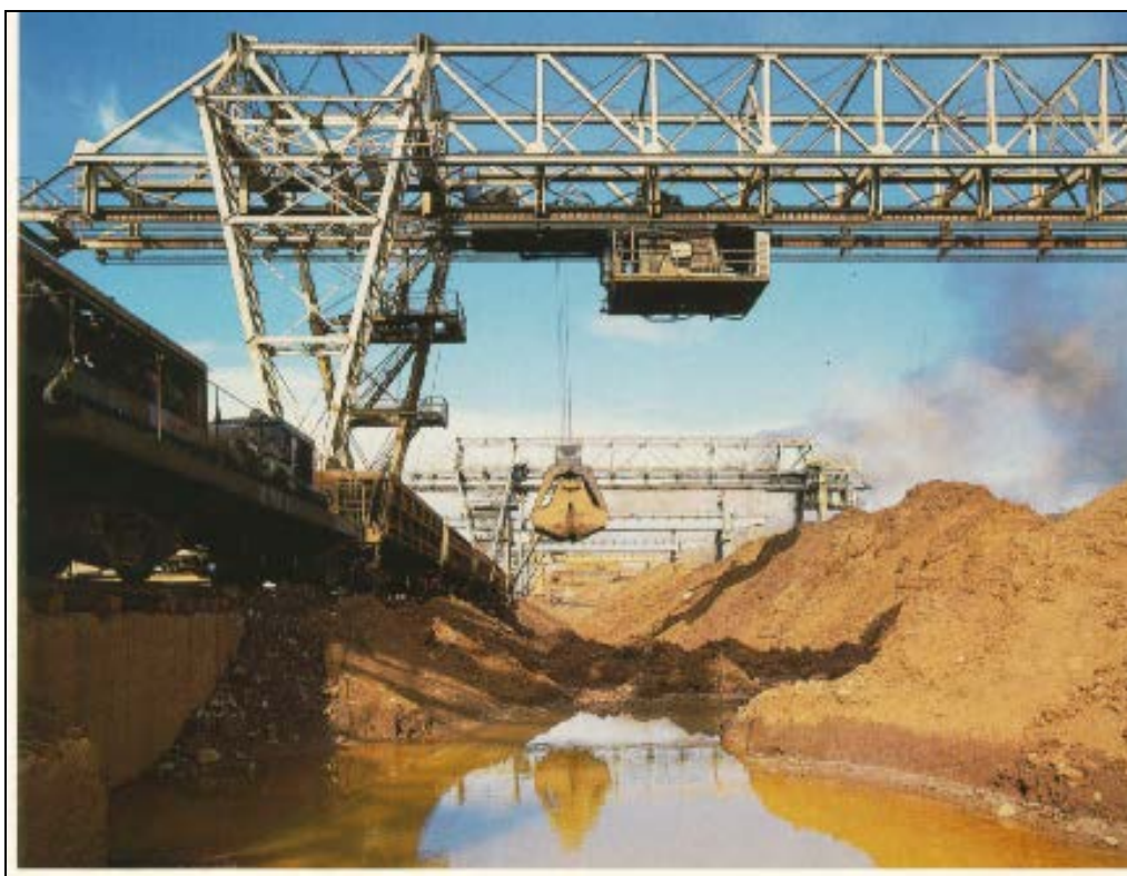
Figura # 2.3 Instalación del Depósito exterior y grúas Gantrys
