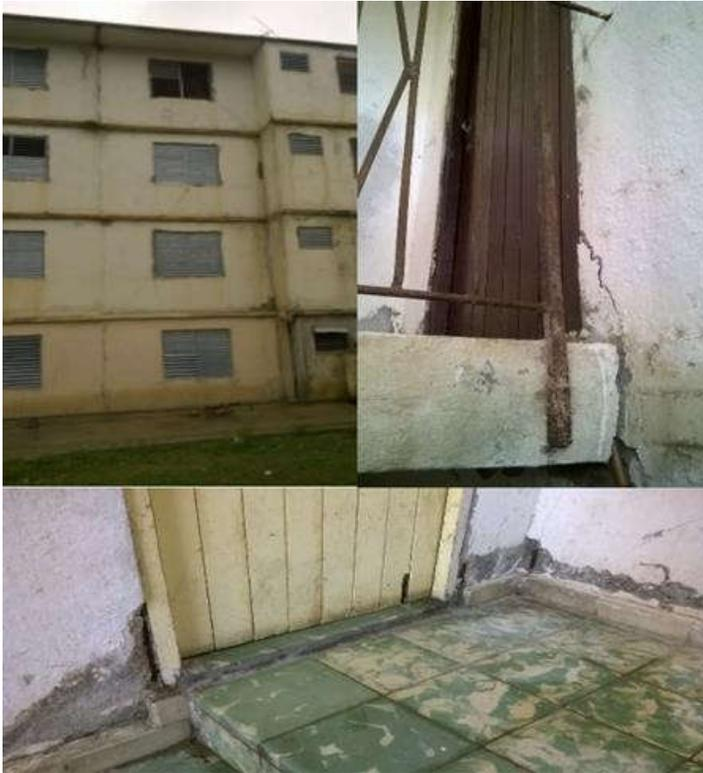
Figura 3.10 Grietas observadas en las edificaciones en la zona central del municipio.
