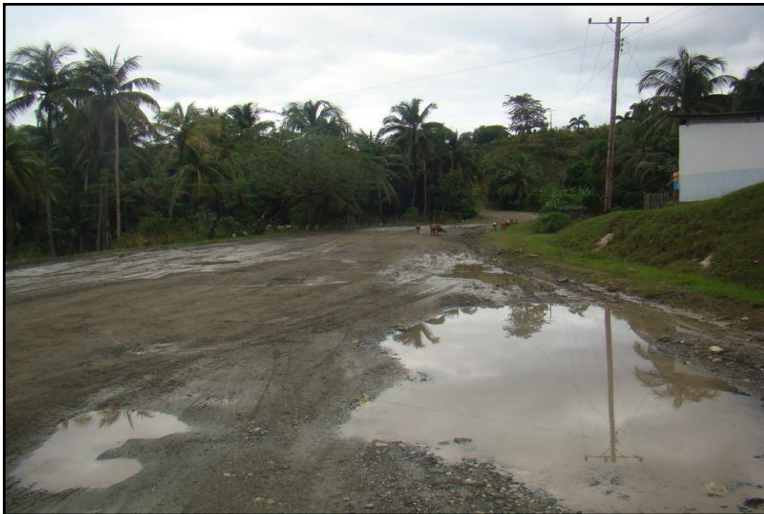
Figura 3.8: foto de agua encharcada en la vía, no se identifican los paseos.
