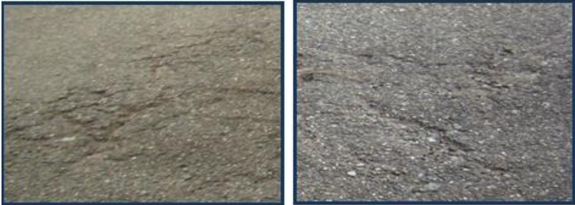
Figura 3.1: fotos de grietas longitudinales y transversales
