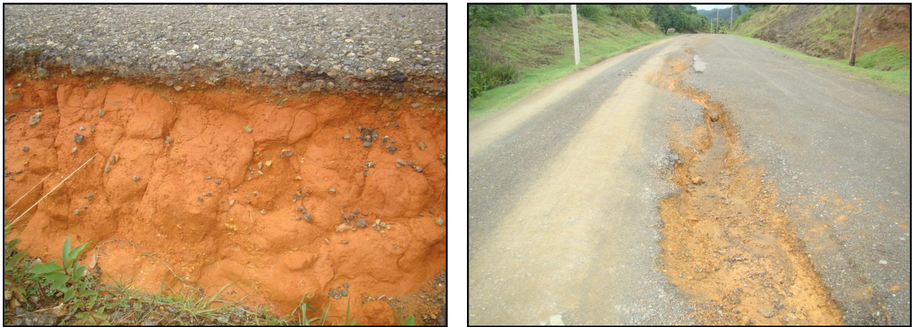
Figura 3.9: presencia de arcillas
