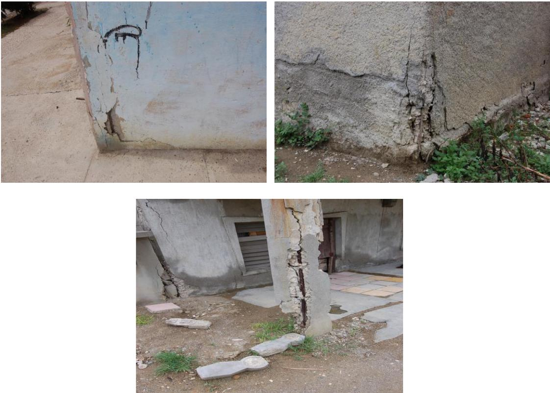
**Figura 2.4:** Fotos que muestran la corrosión de las columnas portantes producto a la cercanía con la Bahía y falta de mantenimiento.
