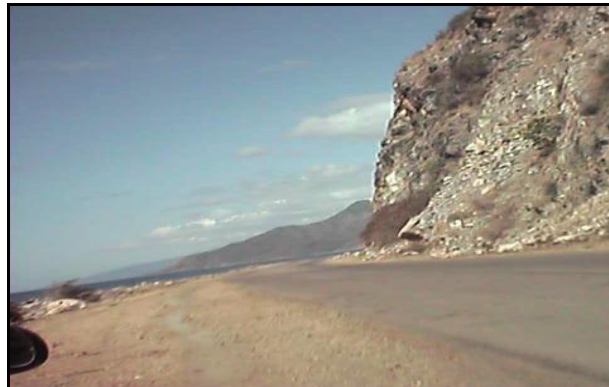
Figura 3.18. Foto talud de la zona Babujal, se observa la pendiente y altura del talud.
