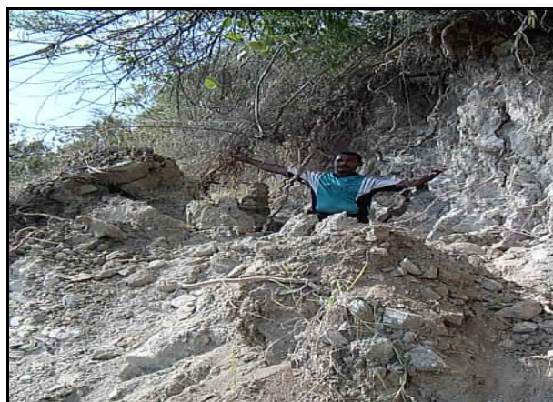
3.17. Foto parte superior del deslizamiento de Loma blanca.
