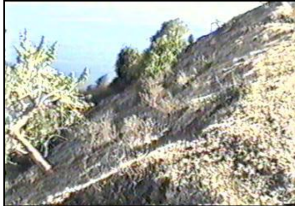
Figura 3.3. Foto Talud Norte, la inclinación del árbol indica el movimiento en el talud.
