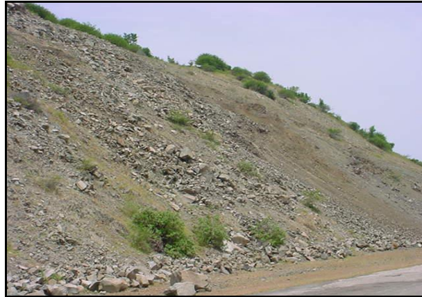
Figura3.7. Foto Talud Norte en la zona de las Llana
