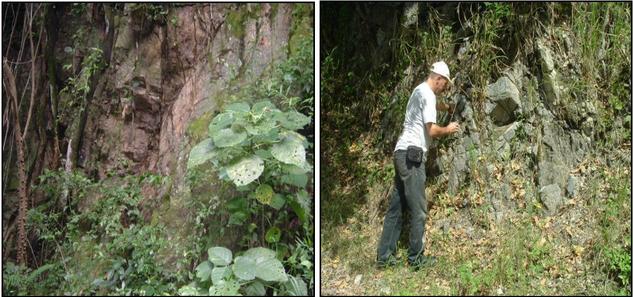
Figura 3.1. Foto taludes donde se observan rocas duras y agrietadas.
