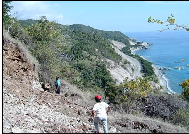
Figura 3.9. Foto vista general del sector de Loma Blanca y la parte superior del deslizamiento principal.
