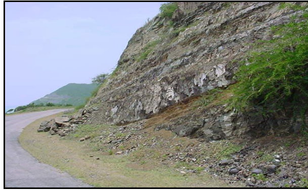
Figura 3.5. Foto Talud situado en la zona de la Zorrilla.
