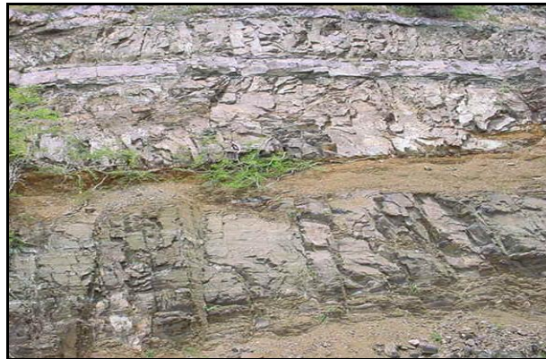
Figura 3.6. Foto Agrietamiento de las rocas en el talud.
