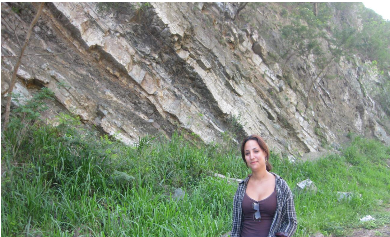
Figura 3.1 Foto talud primer punto
