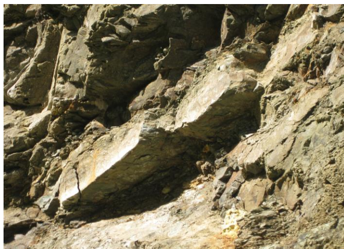
Figura 3.3 Foto talud tercer punto
