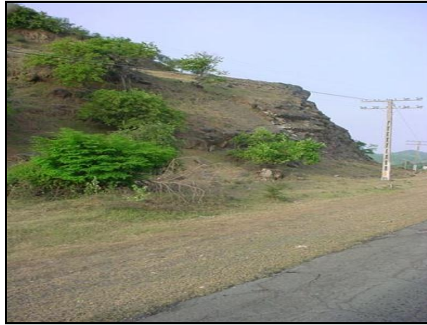
Figura 3.13. Foto talud de la zona Don Luis.
