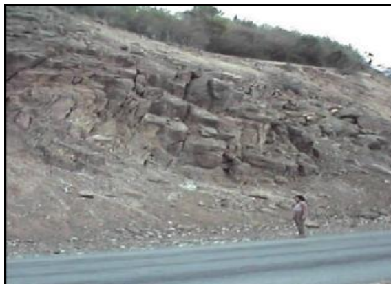
Figura 3.15. Foto talud el Papayo, secuencias de composición vulcanógeno sedimentarias estratificadas, con planos de discontinuidades favorables al ángulo del talud.
