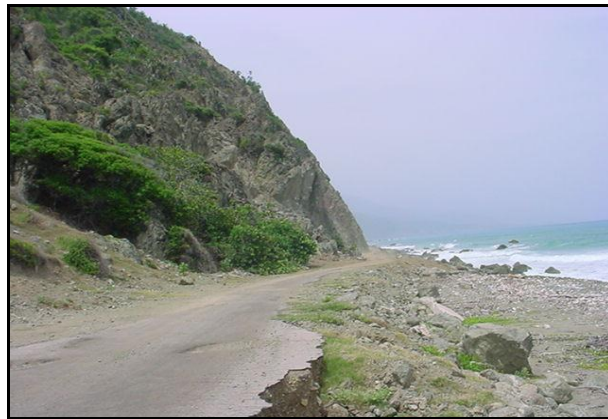
Figura 3.8. Foto talud de la zona La Magdalena.
