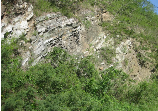
Figura 3.4 Foto talud cuarto punto
