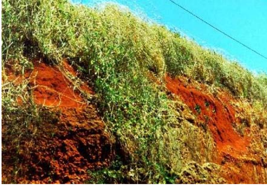
Figura 1.3. Corte en cual aparecen las formaciones Villarroja y la Guevara, en la parte superior e inferior del mismo respectivamente.
