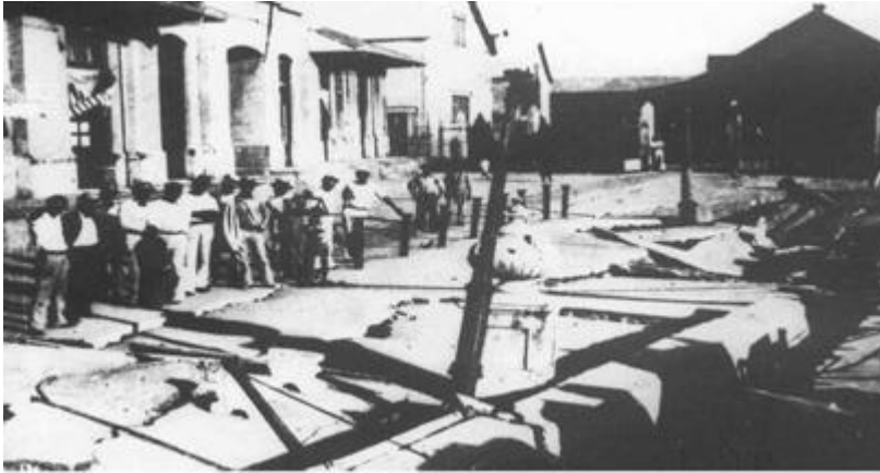
Figura 2: Foto. Licuefacción de los suelos en calle La Alameda, en Santiago de Cuba. Terremoto del 3 de febrero de 1932. Tomado de Herrera, D, 2015
