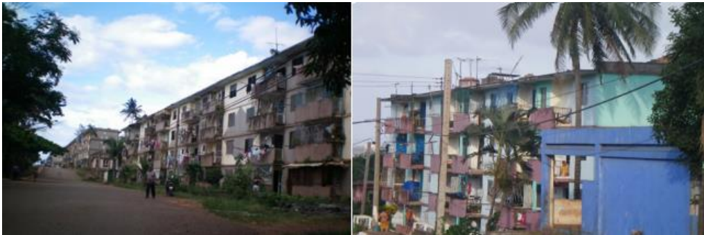
Figura 3.18. Ejemplo de edificios que presentan tipología constructiva de tipo Gran Panel Soviético( GP-IV)
