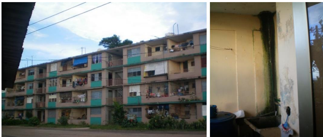
Figura3.21. Ejemplos de edificaciones con la tipología de tipo E14
