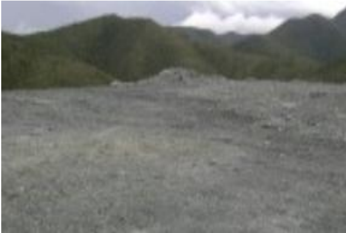
Figura 2.4 Parte superior de la escombrera Túnel Mayarí-Levisa (Tramo I).
