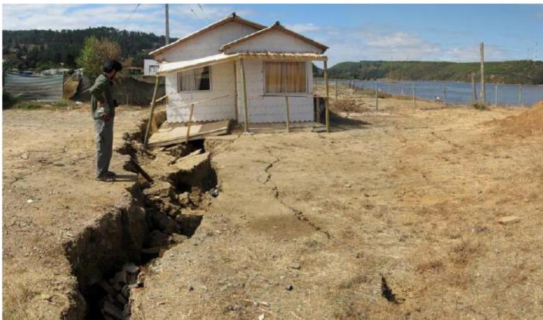
**Figura 1.8** Grietas provocadas por licuefacción del terreno, afectando a una casa en Cahuil.L
