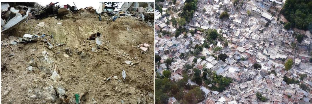
Figura 1.7. Izq. Perfil de los suelos arenosos arcillosos del valle de la Ciudad de Puerto Príncipe, generador de altas intensidades durante el proceso sísmico. Estos suelos son muy licuables. Dcha Se muestra una vista aérea, en planta del terreno, donde todas las viviendas sufrieron grandes daños provocados por su asentamiento en suelos licuables de la ciudad.
