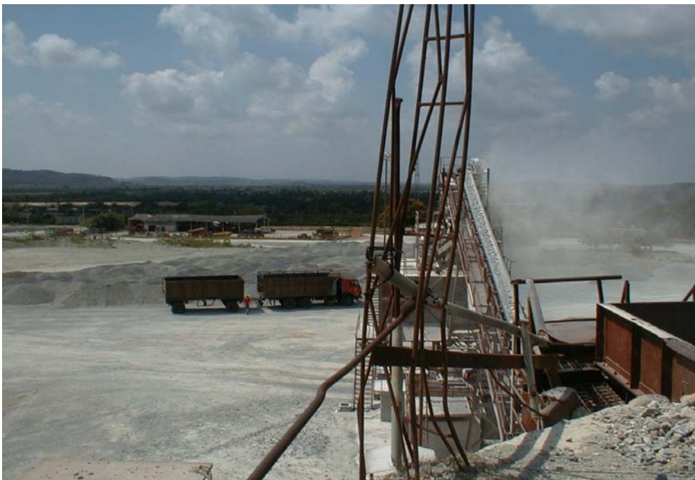
Foto # 1 y 2: Polvo producto al trabajo de la Planta de Preparación Mecánica
